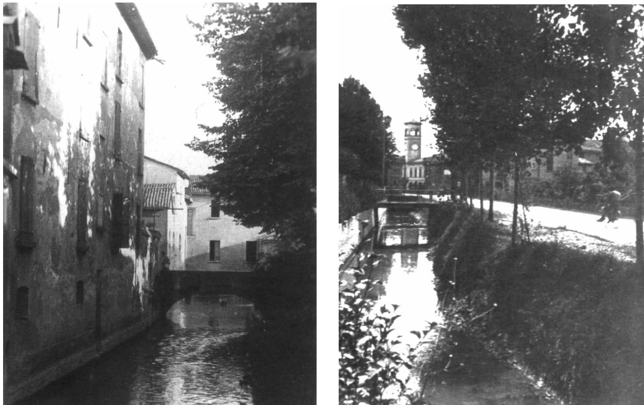
Foto a sinistra: la "Pungela" con il Mulino nello sfondo e, sul lato sinistro, il Macello comunale e Casa Mariani. Foto a destra: Il Canale, a fianco di v. San Mauro, prima della tombinatura.
